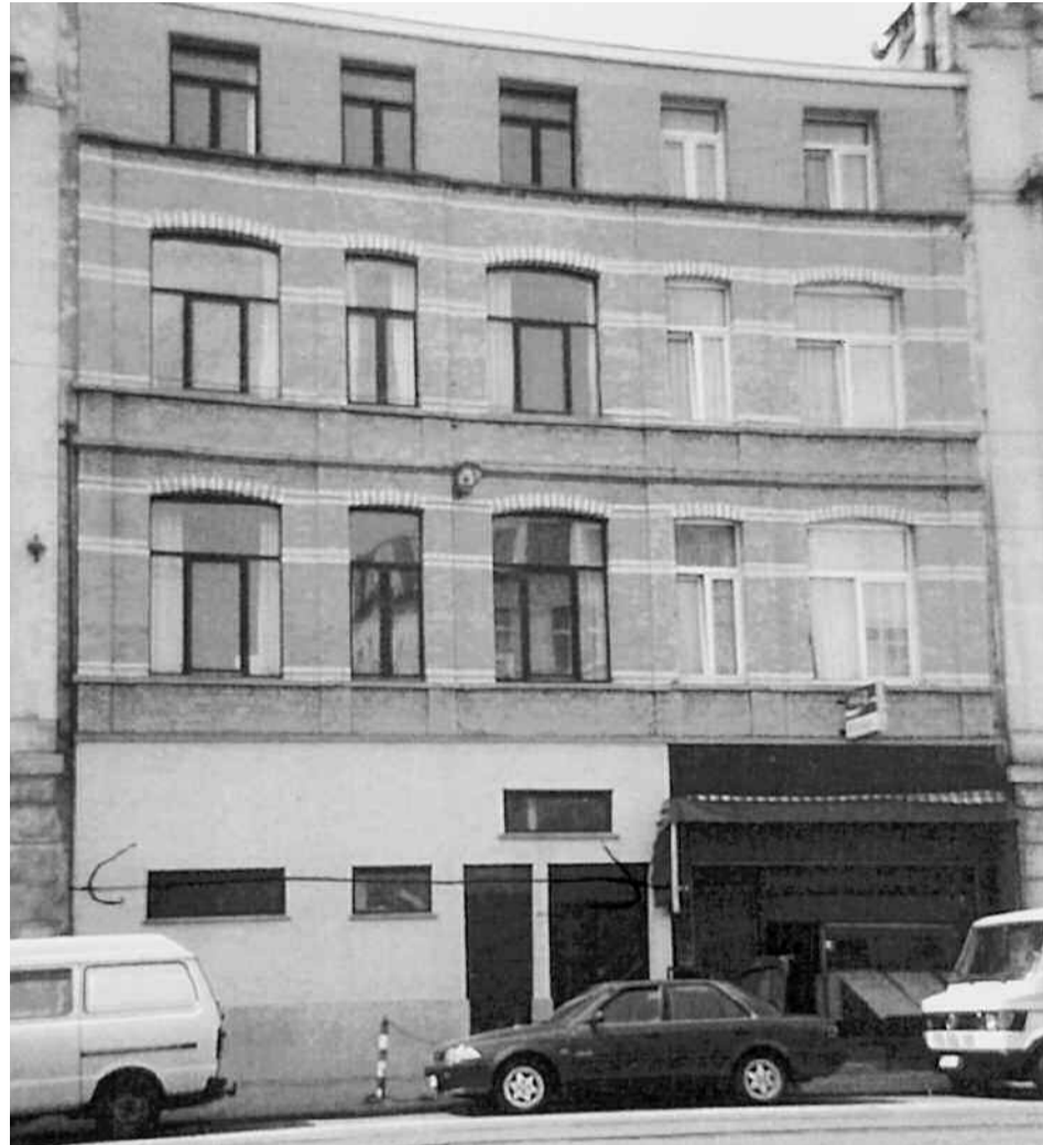
De gevel van het nieuwe dispensarium van Hoboken. Een overheidsgebouw waarvan de Stad Antwerpen afstand heeft gedaan.
